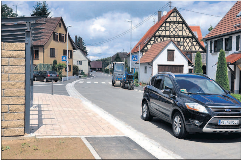
Die neue Ortsdurchfahrt Ebni ist fast fertig. Links die neue Bushaltestelle, fotografiert in Fahrtrichtung Althütte auf Höhe Metzgerei Müller.
